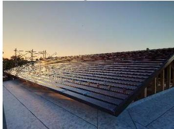
鳥取県東部の新築工事にて押出し形材アルミ屋根“アルピア”を採用頂き、屋根工事を担当しました。
