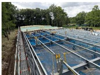
日本一暑い街熊谷市で倉庫・事務所棟と工場棟新築工事を行っています。倉庫棟の鉄骨工事と屋根工事が終わりました。工場棟分の鉄骨が韓国より入ったので、工場棟の工事が本格的に始まります。
