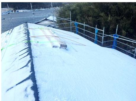
隠岐郡西ノ島町で建築中の施設新築工事にて屋根工事を行っています。耐食性と耐候性に優れたアルピアの押し出し型材アルミ屋根システムを使用しています。
