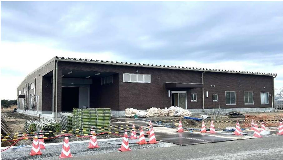
鳥取県西部にて澤井珈琲第4工場新築工事に関わらせていただきました。屋根・壁・樋工事を担当しました。壁は“KMEW はる・一番 ブリオウェーブ”を採用頂きました。水の流れる感じさせる波のような曲線ラインと金属ならではの輝きが特徴です。また、風が強い地域ですので、耐風対策と雪止め金具工事もしっかりと行いました。
