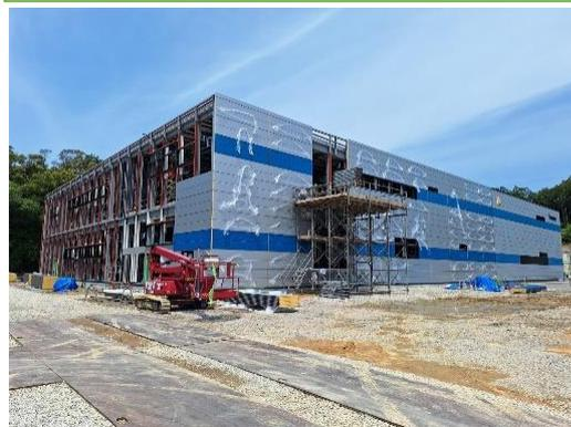
高知県にてY社構造増築工事の外壁断熱パネル工事を担当しました。無事梅雨入り前に作業を終え、残すはシール工事のみとなっています。
