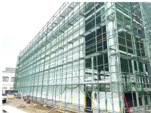
鳥取県東部の現場にて、屋根・外壁工事を担当しています。韓国から到着した外壁断熱パネルを用い外壁工事が始まりました。下5段目がホワイト、6段目以降はベージュという素敵なコントラストになっています。
