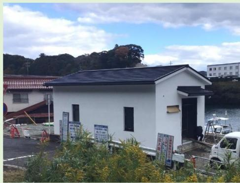
島根県隠岐の島町にあるポンプ場新築工事にて、屋根工事を担当しました。アルピアの押し形材アルミ屋根を用いましたので、「耐風」「塩害」「雪害」「地震」に強い屋根となっています。
