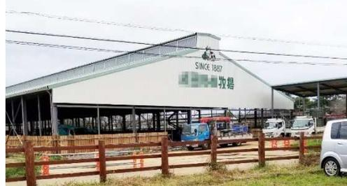
千葉県成田市の牛舎及び堆肥舎新築工事ですが、引き続き進行中です。牛舎の屋根葺きが終わり、足場解体もしました。外壁に牧場名等のペイントが終わり、牛舎の存在感が増しました。内部工事が始まります。
