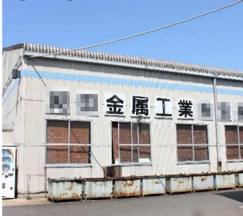
島根県東部にあるA金属工業にて屋根及び外壁の改修工事に関わらせて頂きました。以前リバースが担当し、隣に新築で建てられた倉庫は、屋根がガルバリウム鋼板、壁は断熱パネルで出来ており、とても快適とのこと。今回改修の倉庫は屋根、壁共にスレートだった為、夏がとても暑く環境のあまりに違いに社員の皆さんからも相談があり、今回の改修となりました。屋根はスレート工法でガルバリウム鋼板へ、壁は断熱パネルへと改修しました。隣接する倉庫同様、夏の暑さは勿論、冬の寒さも緩和されると思います。
